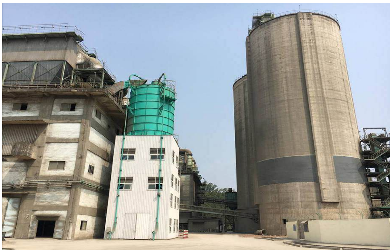
Silo chứa tro bay tại Nhà máy Xi măng Nghi Sơn – Thanh Hóa/ Fly ash silo at Nghi Son Cement Corporation - Thanh Hoa province
