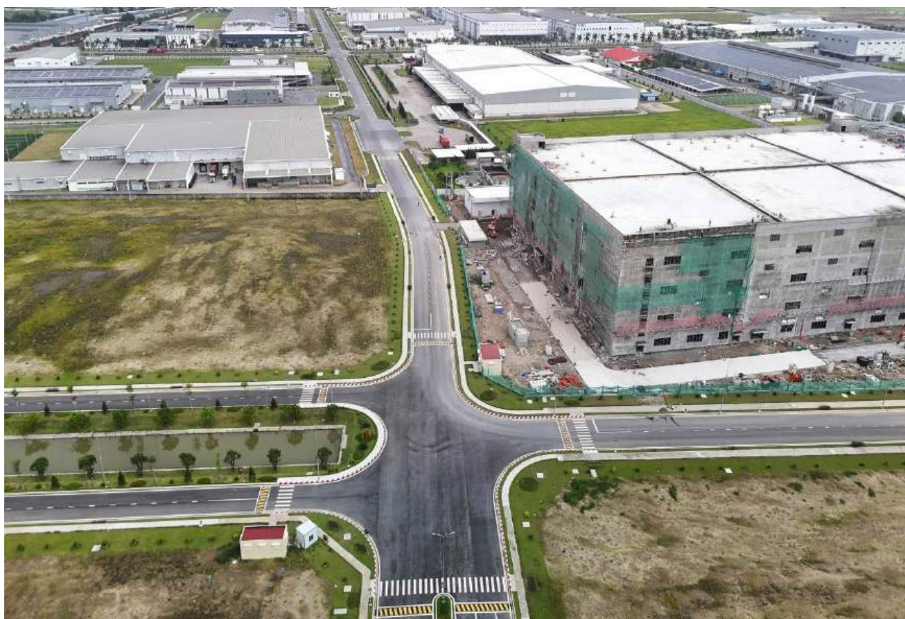
Hạ tầng kỹ thuật Khu công nghiệp Thăng Long II (giai đoạn 3)/ Technical infrastructure of Thang Long Industrial Park II (phase 3)
