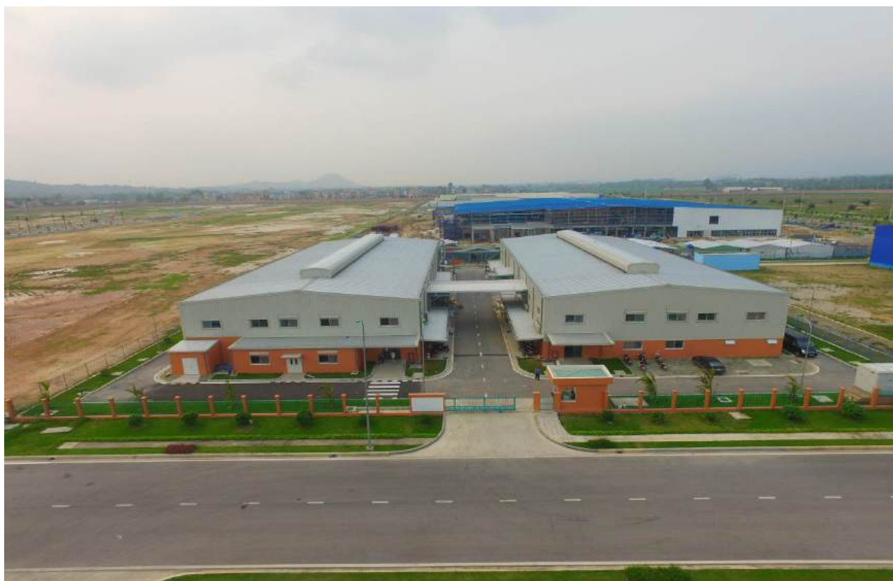
Nhà máy cho thuê số 1&2 tại Khu Công nghiệp Thăng Long (Vĩnh Phúc)/ Rental factory No. 1&2 - Thang Long (Vinh Phuc) Industrial Park
