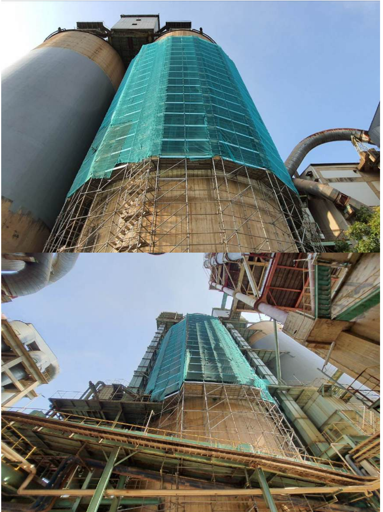
Sửa chữa Silô bột liệu số 1 thuộc dây chuyền 2 – Nhà máy Xi măng Nghi Sơn Repairing damaged Wall of No.1 blending silo in 2nd line – Nghi Son Cement Pant
