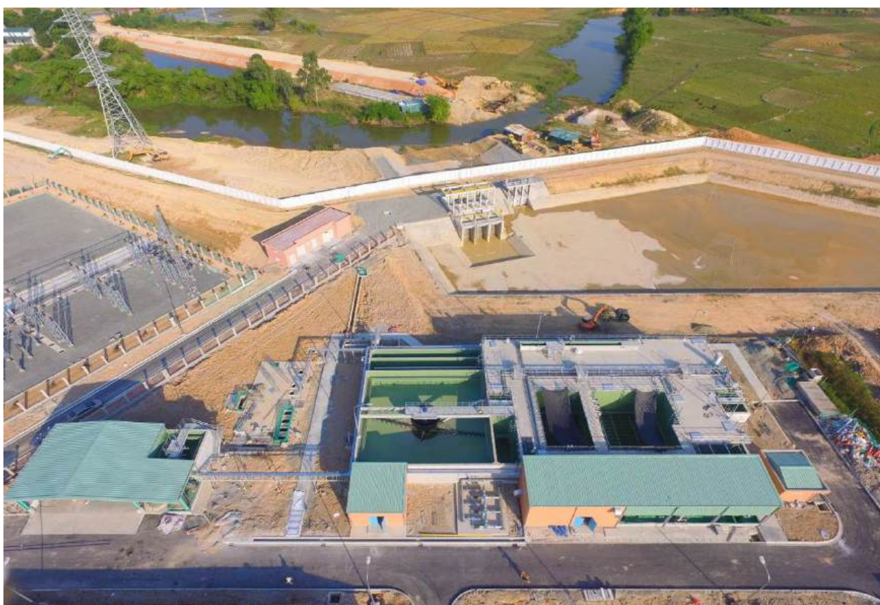
Hạ tầng Khu Công nghiệp Thăng Long (Vĩnh Phúc)/ Thang Long Industrial Park (Vinh Phuc) project
