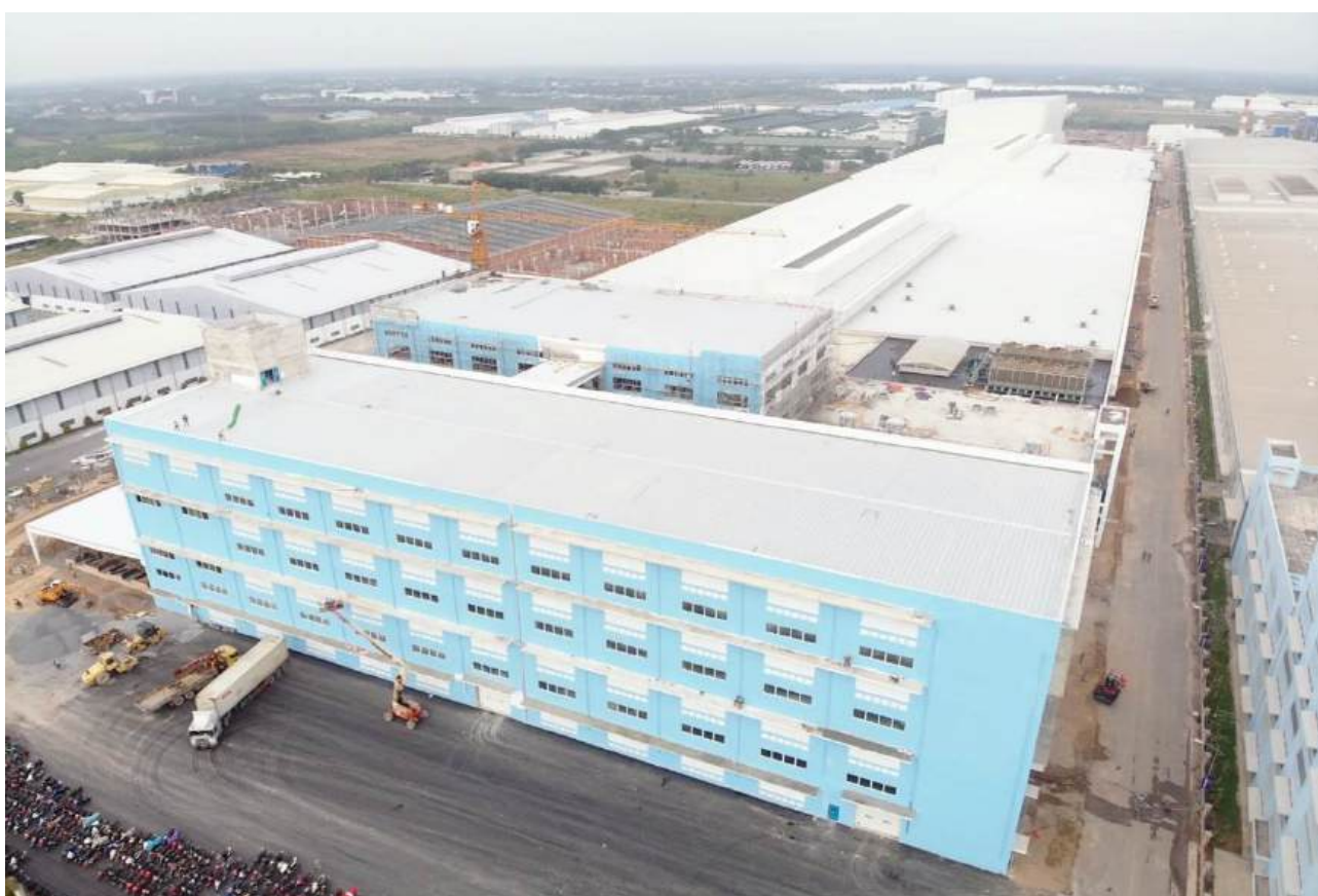
Nhà máy chế tạo lốp xe radian toàn thép ACTR – Tây Ninh/ ACTR all-steel radian tire Factory – Tay Ninh province
